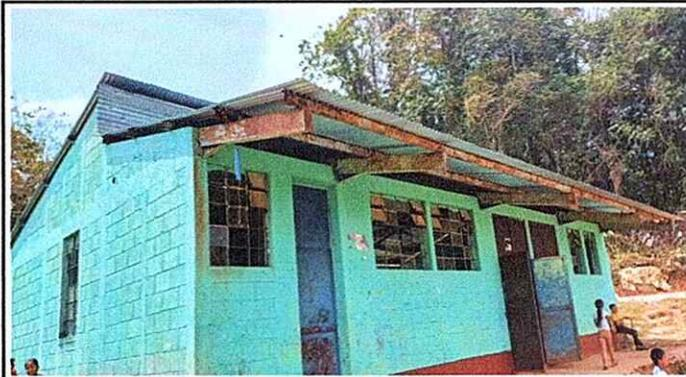
Foto 2: Se observa el deterioro de las costaneras.
